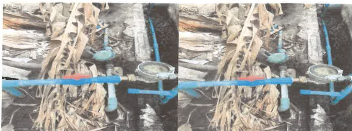
งานบำรุงรักษาและซ่อมแซมบริเวณหน้าบ้านนายประมาณ ล้ากลาง ถนนเทศบาล ๘ ท่อจ่ายน้ำประปาขนาด ๑๒ x ๑/๒ นิ้ว หมู่ที่ ๙
